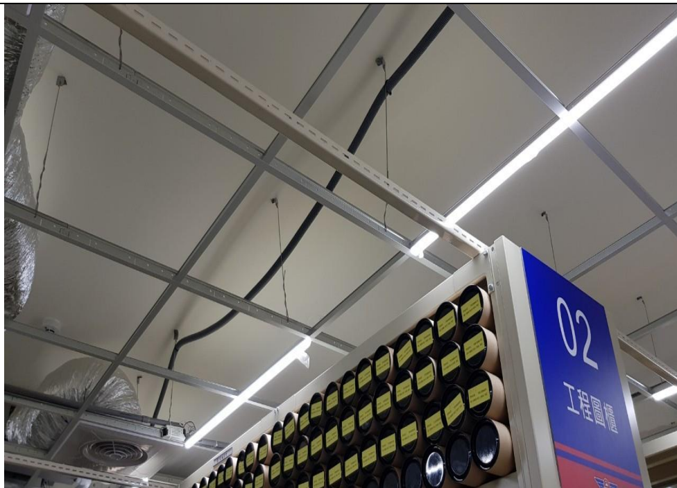
固定櫃間安裝鐵架以避免地震倒塌
